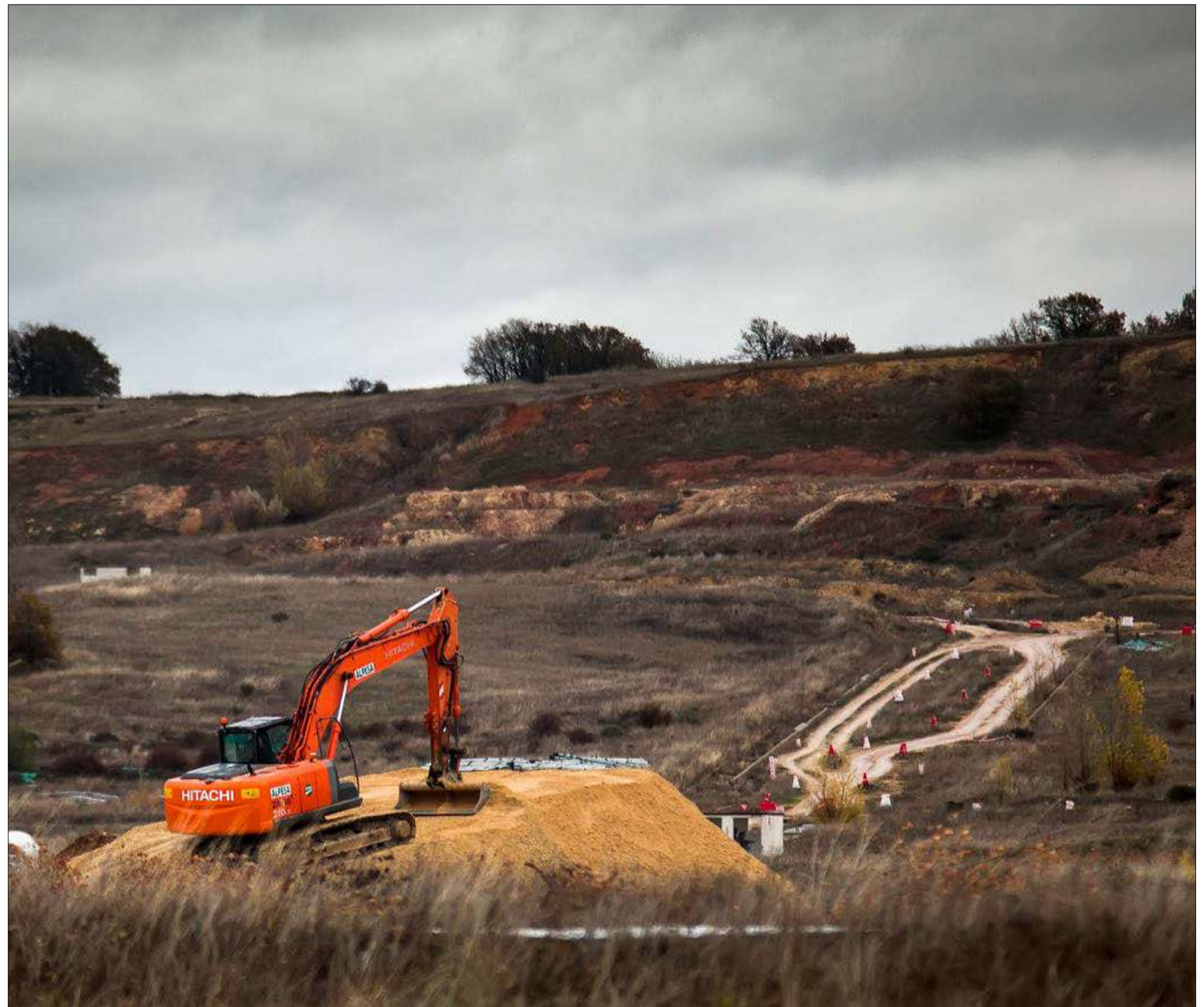
Los trabajos en el Parque Tecnológico se reanudaron en agosto de 2023 y se prolongarán hasta 2025. TOMÁS ALONSO
