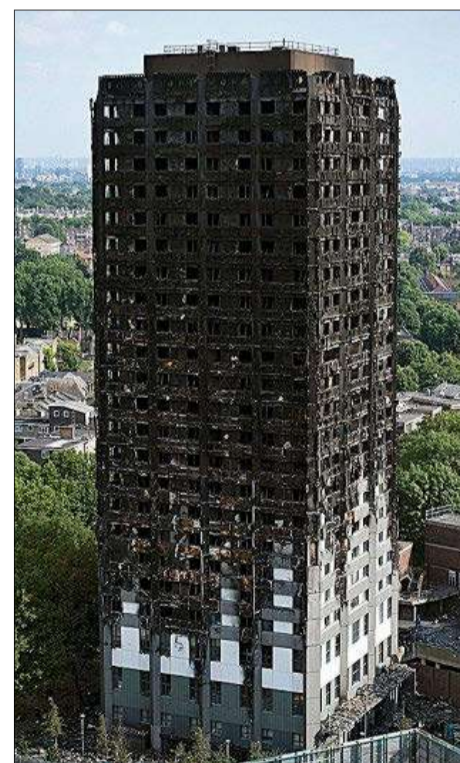
La torre Grenfell, tras el incendio. EFE
